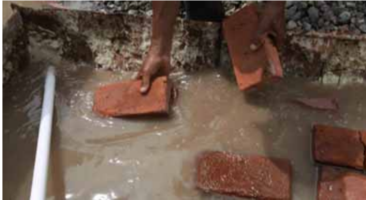
Gambar 15. Perendaman Batu Bata Sebelum Dipasang
