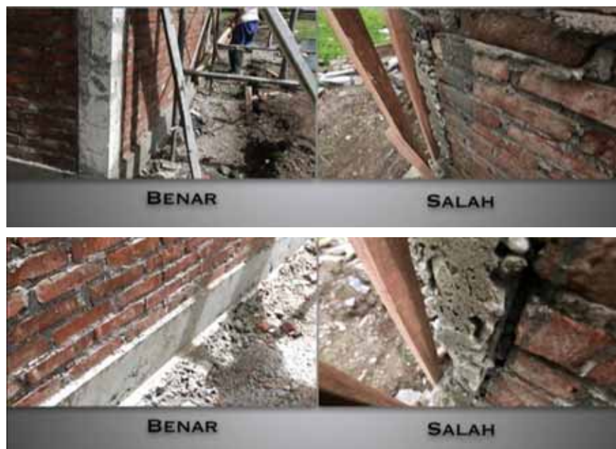
Gambar 58. Hasil Pengecoran
