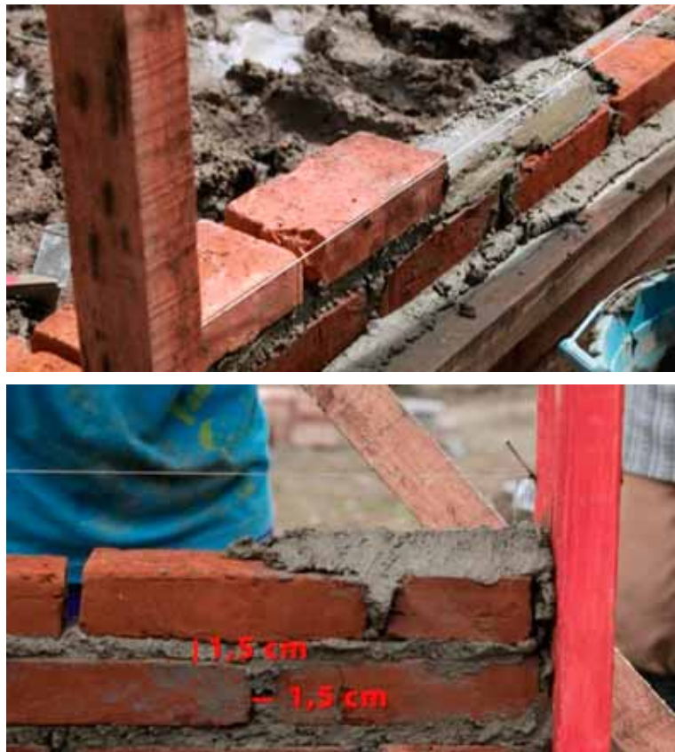
Gambar 41. Proses Pemasangan Batu Bata Untuk Dinding
