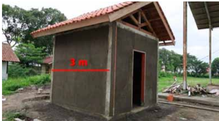
Gambar 42. Luas Maksimum Dinding dan Jarak Maksimum Antar Kolom
