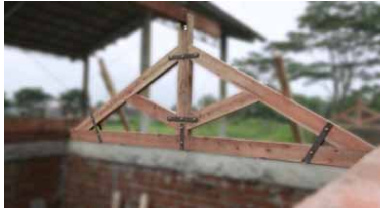
Gambar 28. Kuda-kuda Kayu Dengan Pengikat Plat Baja
