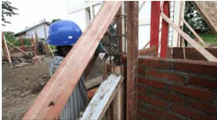
Gambar 56. Proses Pengecoran Kolom
