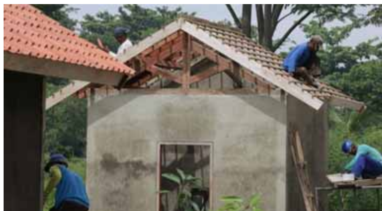
Gambar 27. Kuda-kuda Kayu Pada Atap Rumah Tinggal
