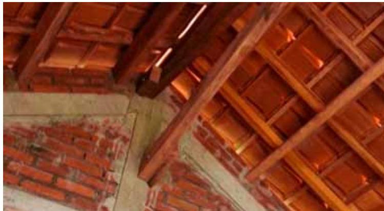
Gambar 37. Pertemuan Antara Ikatan dengan Gunung-Gunung/ Ampig
