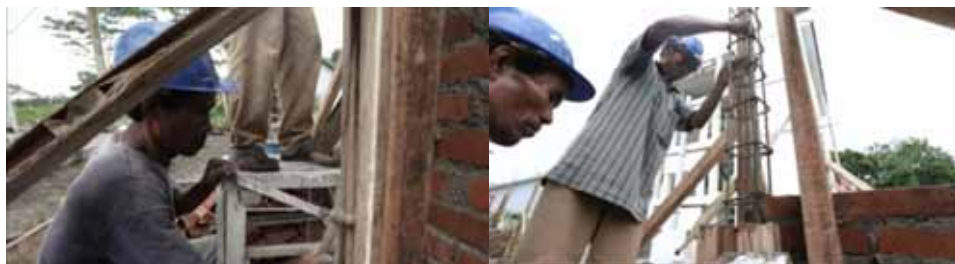
Gambar 57. Pemadatan Beton Dengan Memukul-mukul Cetakan/ Bekisting dan Campuran Beton Dirojek Menggunakan Besi atau Bambu
