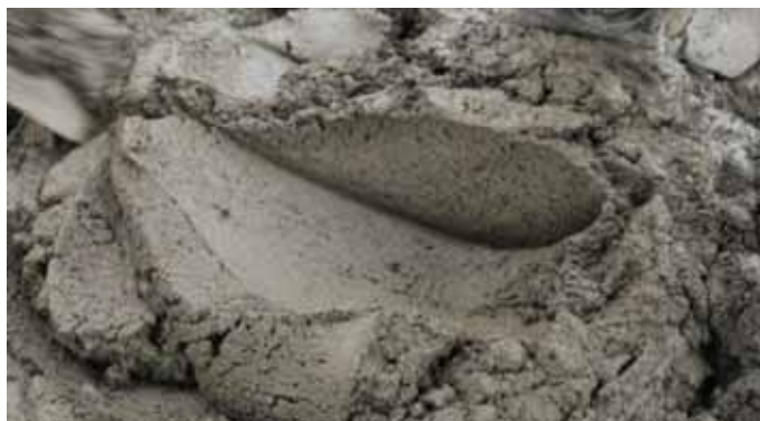
Gambar 9. Hasil Pencampuran Mortar Yang Baik
