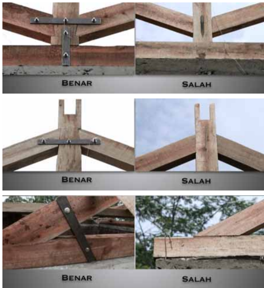
Gambar 29. Pemasangan Plat Baja Pada Kuda-kuda Kayu
