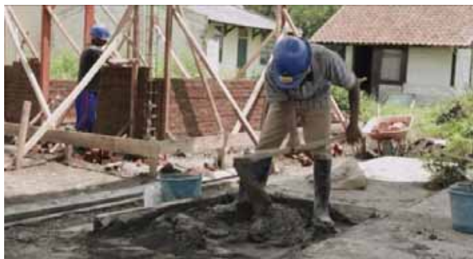
Gambar 8. Proses Pencampuran Mortar
