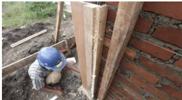
Gambar 55. Pemasangan Cetakan/ Bekisting Untuk Kolom
