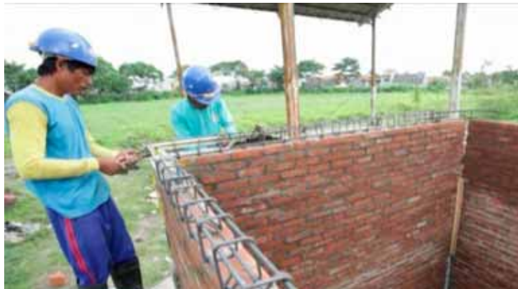
Gambar 58. Pengecoran Balok Pengikat/ Sloof
