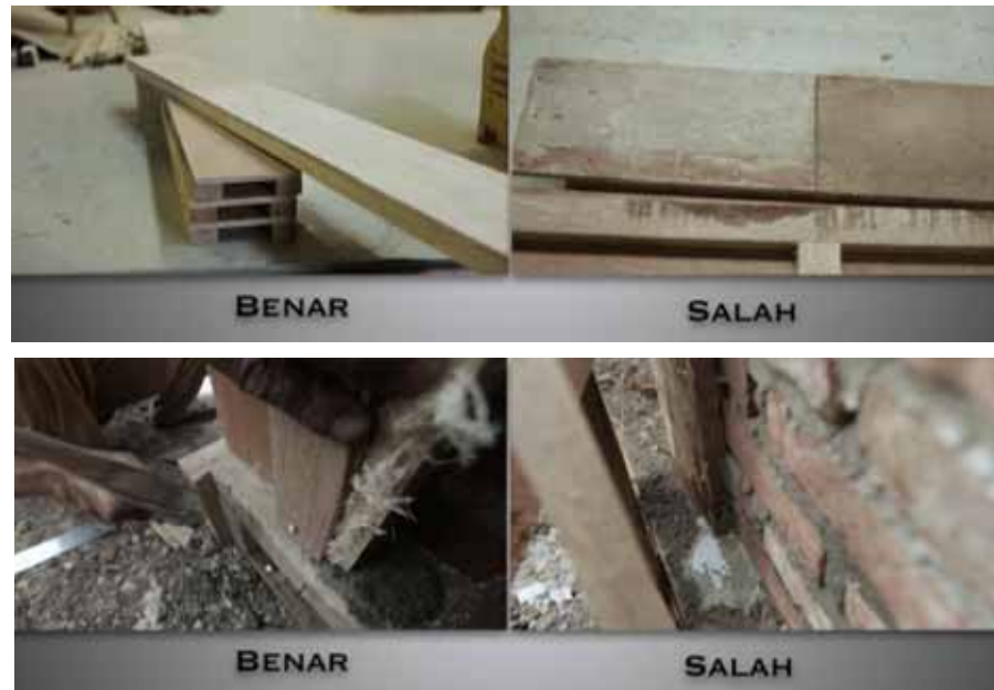
Gambar 54. Kualitas Cetakan/ Bekisting
