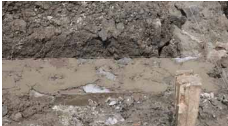
Gambar 11. Pondasi Dari Batu Kali/Gunung
