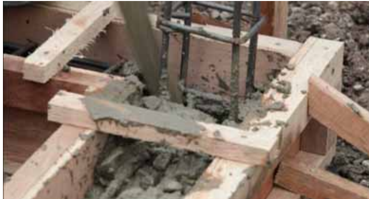
Gambar 58. Pengecoran Balok Pengikat/ Sloof
